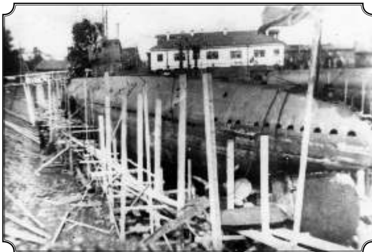
Подводная лодка Д-1 в постройке
