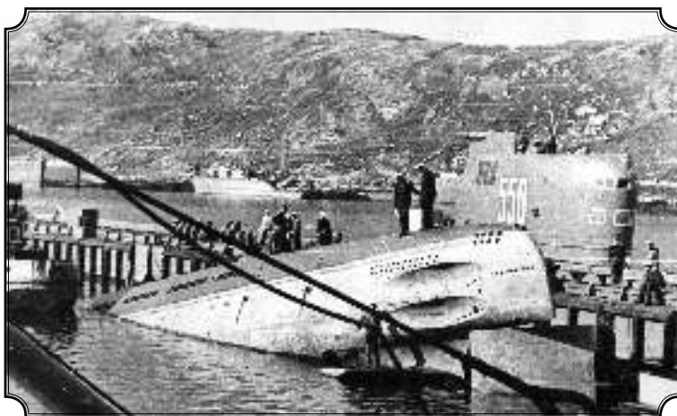
Работы по подъему подводной лодки Б-37
