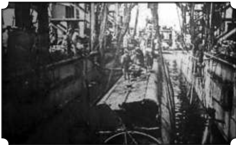
Подводная лодка Б-3 на спасательном судне «Коммуна» («Волхов»). 2 августа 1935 года
