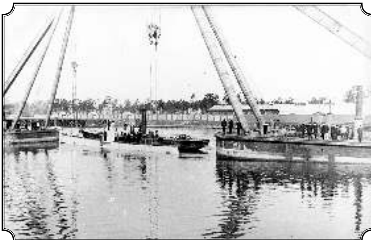
Подводная лодка «Минога» поднята в ходе спасательных работ после аварии
